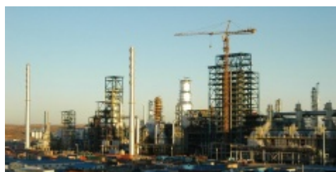
神华电厂工地
